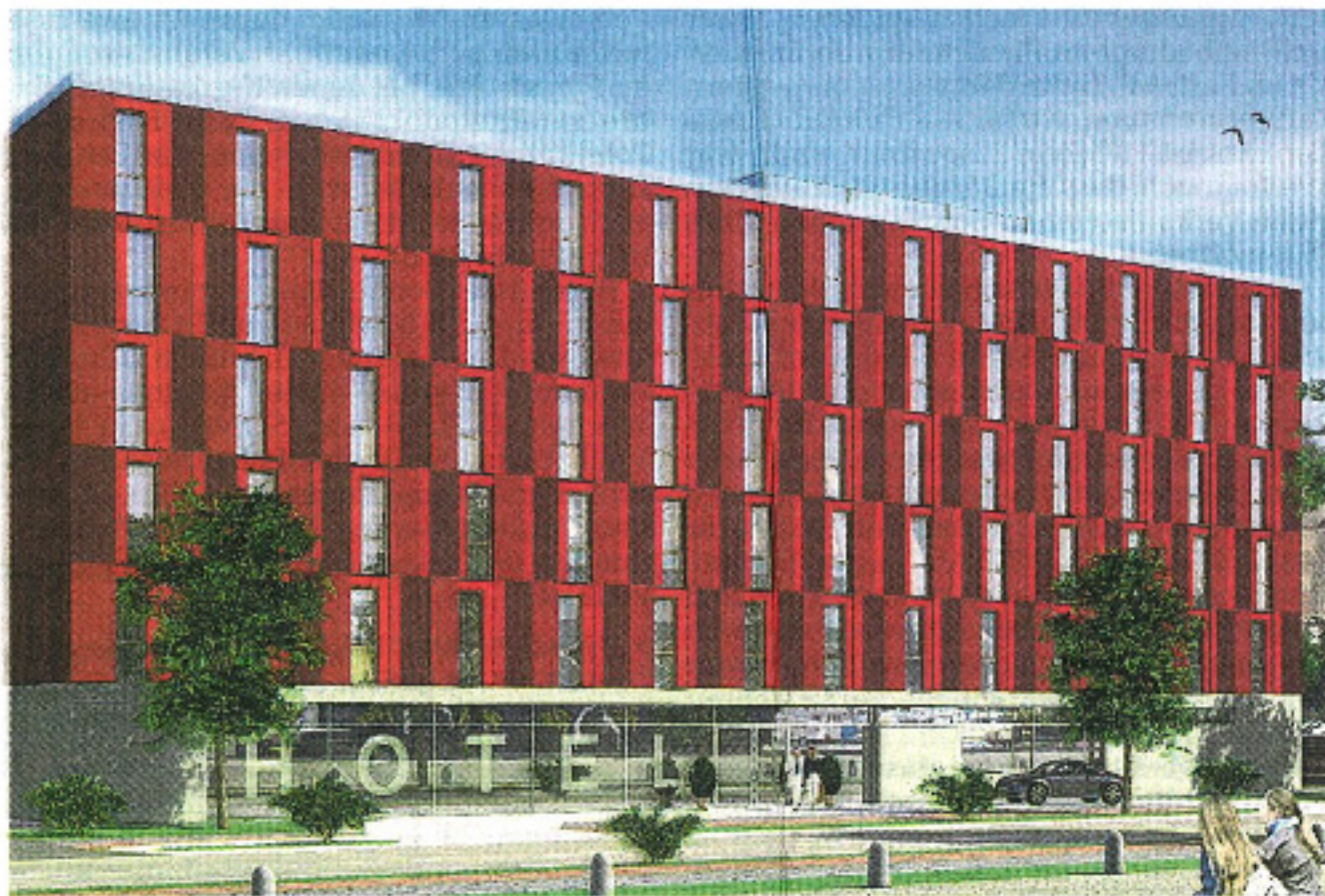
Das „Prizeotel“ an der Theodor-Heuss-Allee wird gegenüber vom Haupteingang zur Bürgerweide stehen. Der Grundstein ist bereits gelegt.
